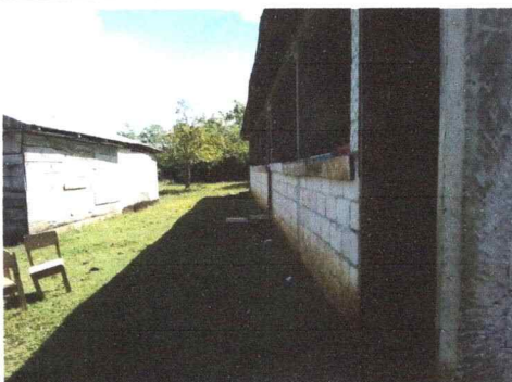
Foto 5: Colocación de Torta de cemento en el corredor.
