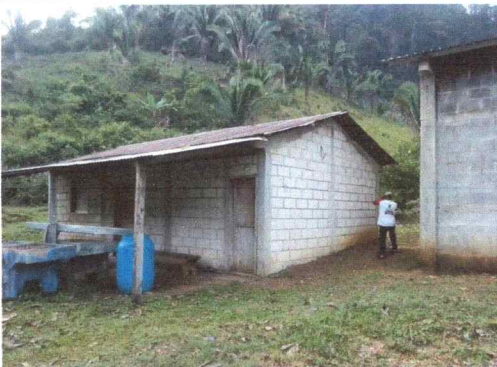
Foto 3: Colocación de techo, repello y corredor de la cocina
